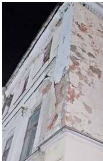
▲ Куски штукатурки сыпятся со стен прямо на тротуар
